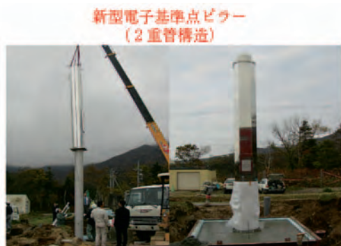
写真－1 2002年新型ピラー建設
