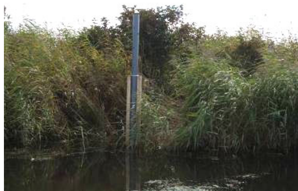
写真－3 ペンケ沼に設置した水位観測所
