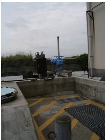
写真-11 片山津水位観測所
