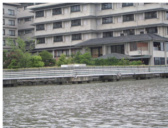
写真-12 パイプライン
