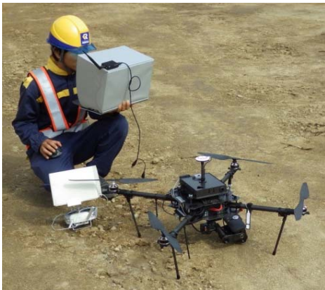
出来形管理測量のUAV
