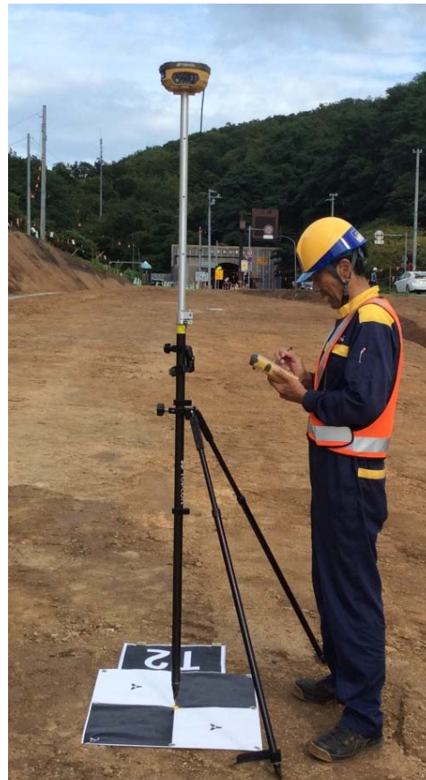
(出来形管理) 標定点の測定
