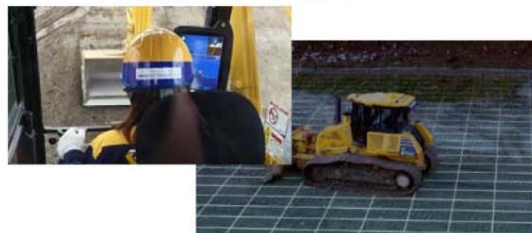
ICT建機による施工
