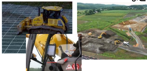
ICT建機での施工
