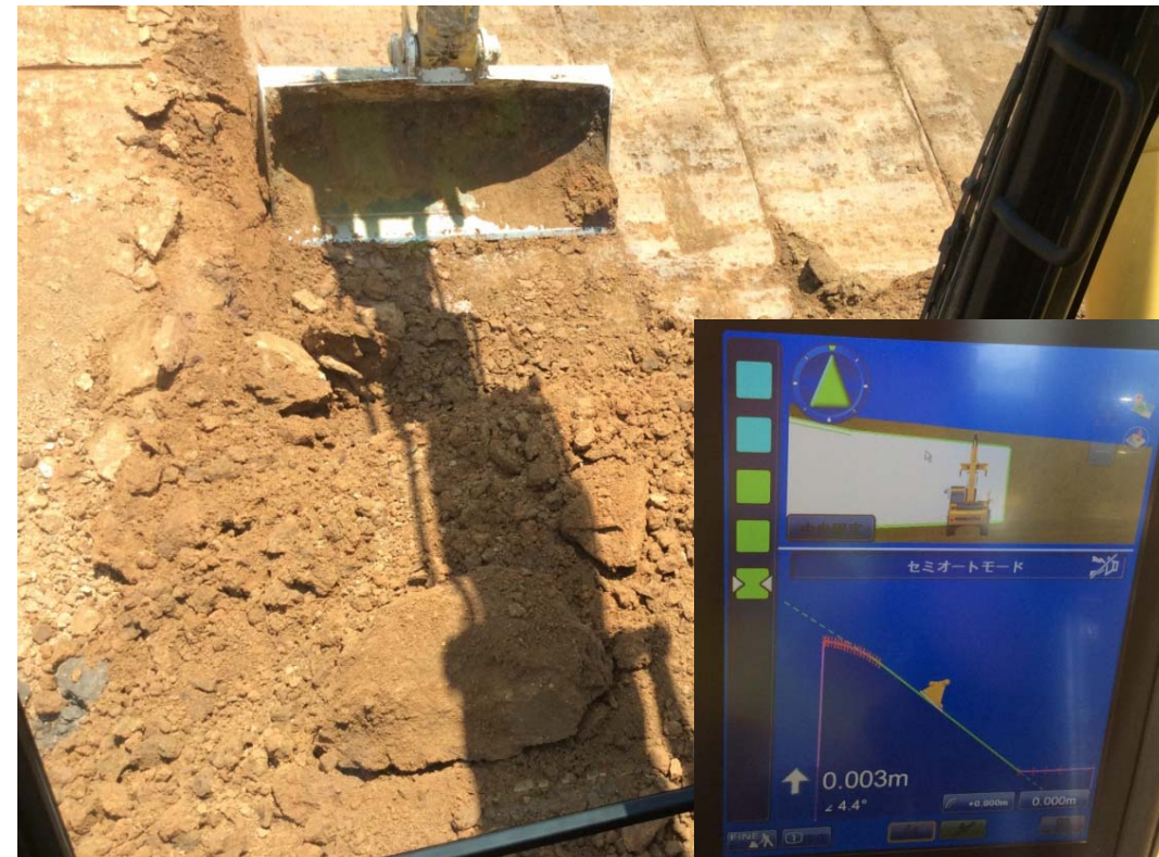
ICT建機による法面整形施工状況
