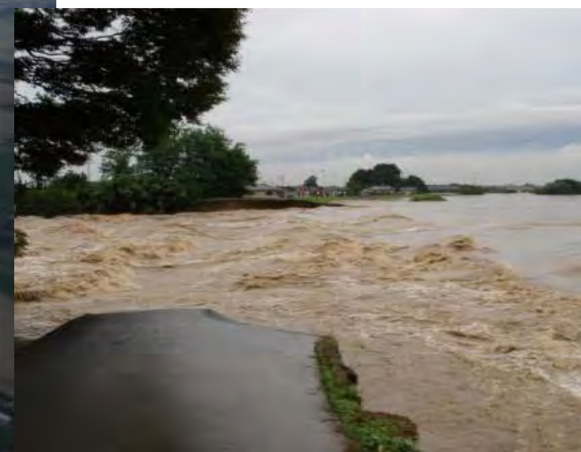
被災状況(拡大写真)
