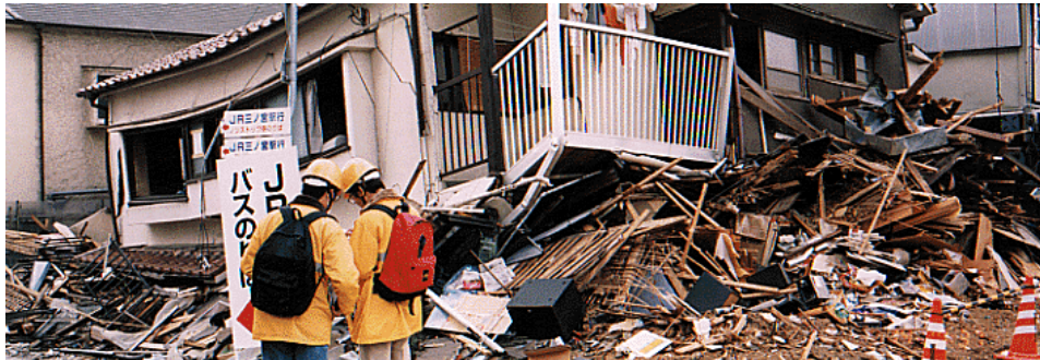
住吉駅南部の緩扇状地の建物の被害状況
