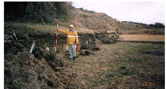
北淡町野島平林の断層亀裂
