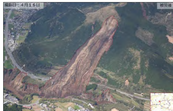
土砂災害（阿蘇大橋周辺）（4月16日撮影）
