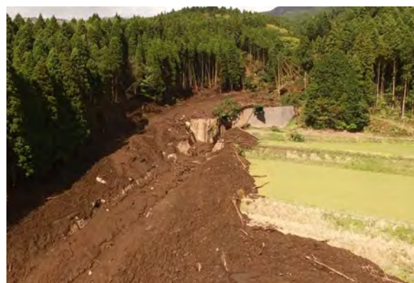
山王谷川土砂崩れ（4月17日撮影）
