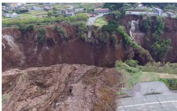
阿蘇大橋周辺の土砂崩れ箇所（4月16日撮影）
