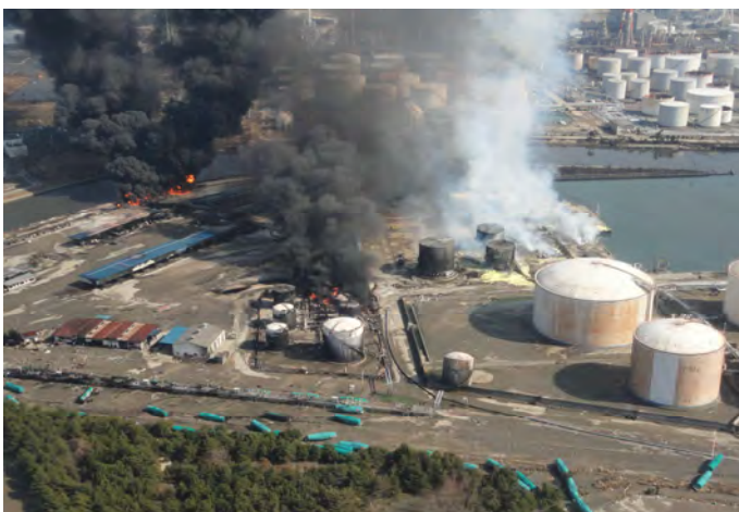
地震をきっかけとする火災(東北地方太平洋沖地震) (出典: 宮城県七ヶ浜町)
