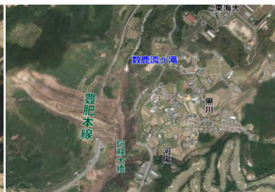
地滑り発生後(熊本地震)
