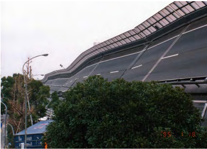
高速道路の倒壊(兵庫県南部地震)(写真提供:神戸市)
