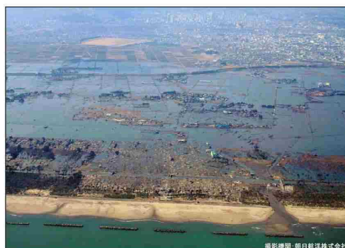
仙台市若林区(荒浜地区) (3月12日撮影)
