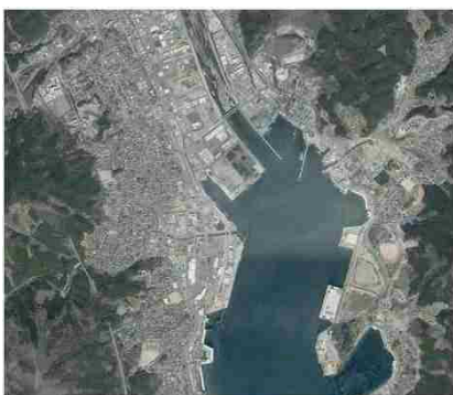
震災後（平成31年4月撮影）
