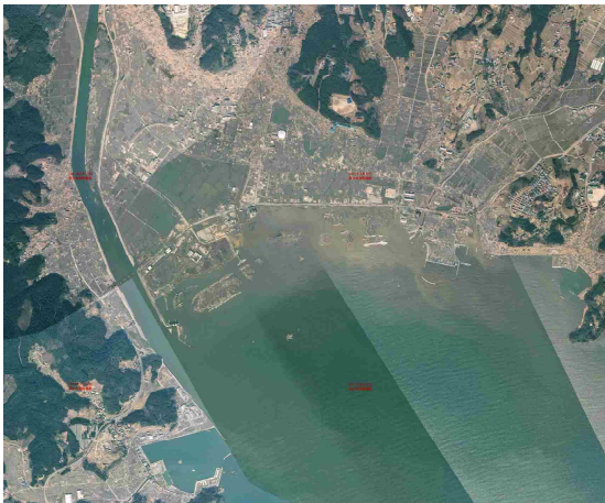
震災直後（平成23年3月12日撮影）
